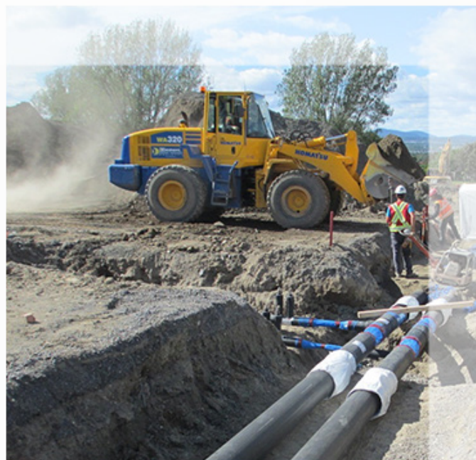
Travaux d'installation de la tuyauterie
